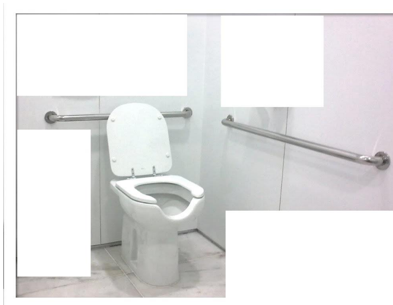
Vaso sanitário padrão PNE e barra de apoio tipo L
